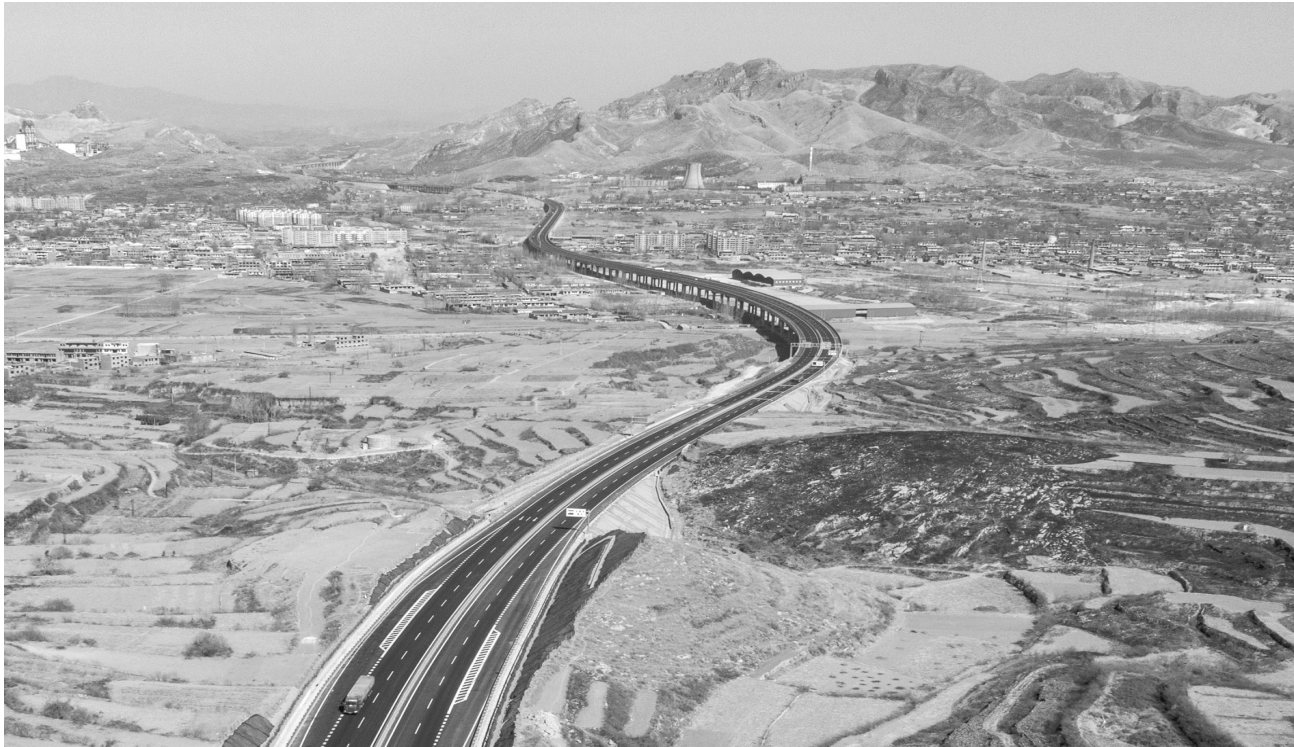
俯瞰保阜高速曲阳县灵山高速桥段。
