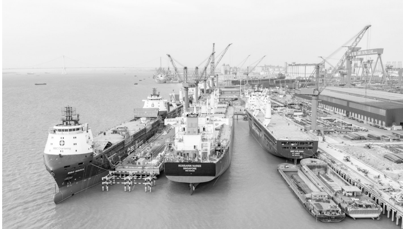
1月11日,在位于江苏省泰州市高港区的泰州三福船舶工程有限公司生产基地,多艘大型船舶在建造中(无人机照片)。新华社发
