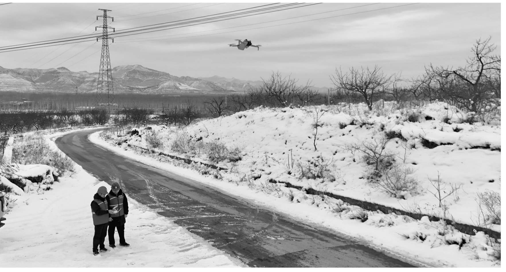
无人机已成为电网智能巡检的“空中哨兵”。它搭载高清与红外设备,自主穿梭复杂环境,精准识别隐患并实时回传数据,实现高效、安全、智能的运维作业,筑牢电网安全防线。图为1月23日,国网保定供电公司员工在涞水山区利用无人机进行线路巡视作业。 张宏伟 摄
