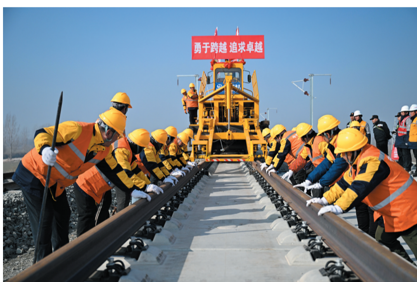
雄忻高铁进入铺轨施工阶段
