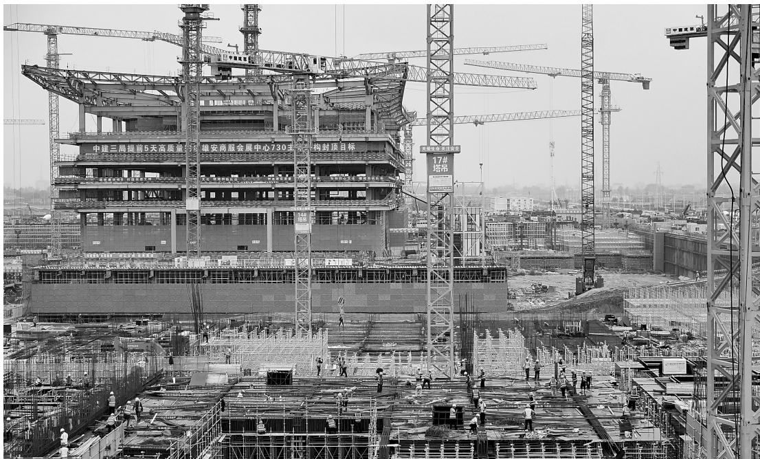
工人在雄安新区商务服务中心建设现场施工(8月13日摄)。雄安新区2020年谋划提出百余个重点建设项目,截至7月底,近70个项目已主体开工或配套辅助设施工程开工。
