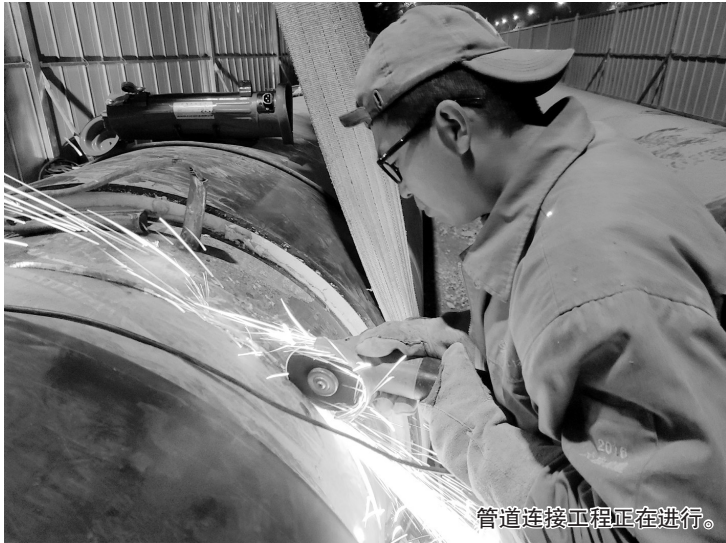
预计在11月中旬前,所有工程都将完工。
