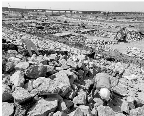
河堤正在铺设石笼。
