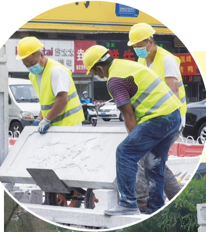
8月17日,在竞秀区向阳桥维修改造现场,施工人员正在为桥体安装更加坚固、美观的新护栏。据介绍,5月下旬开始,我市主城区内30座桥梁开始维修保养改造,通过加固受力结构,更换附属设施,修复破损外表等工程,实现桥梁使用年限的延长。 侯斌 摄
