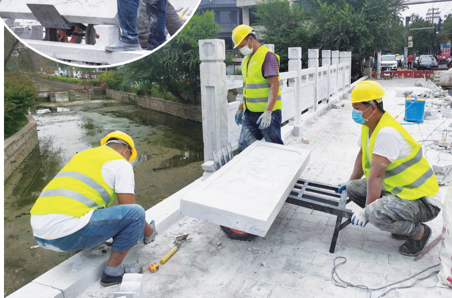
8月17日,在竞秀区向阳桥维修改造现场,施工人员正在为桥体安装更加坚固、美观的新护栏。据介绍,5月下旬开始,我市主城区内30座桥梁开始维修保养改造,通过加固受力结构,更换附属设施,修复破损外表等工程,实现桥梁使用年限的延长。 侯斌 摄
