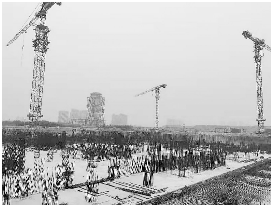
无缝连接。中国古动物馆(保定自然博物馆)项目建设现场现已全面开展冬季施工措施
