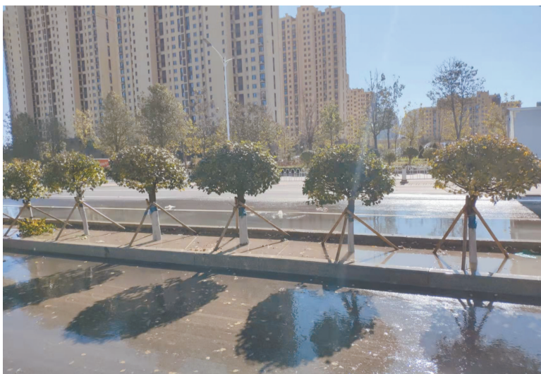
▲全民健康智慧产业园区附近的复兴路上,有污水外溢,臭味很大。 李勇超 摄
