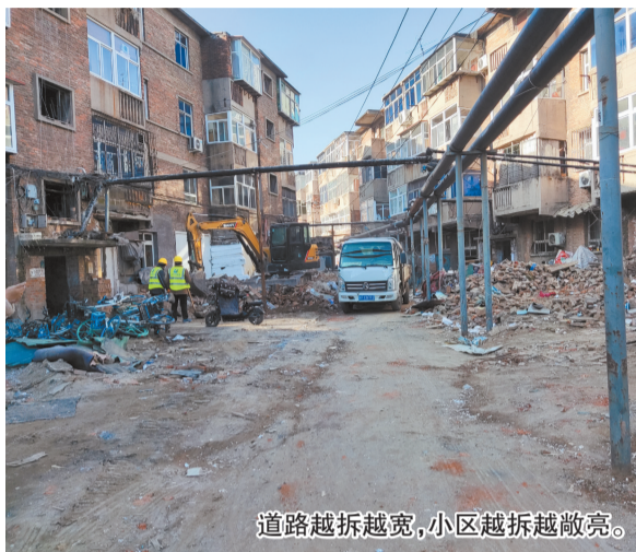
工人正在对拆违后的楼体进行恢复。
