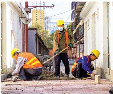
2020年莲池区市直机关第六生活区改造施工现场，工人铺设地砖。
