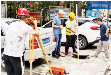
2021年莲池区中华小区改造施工现场。
