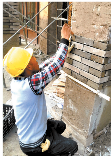
工人师傅正在粘贴青砖贴片。
