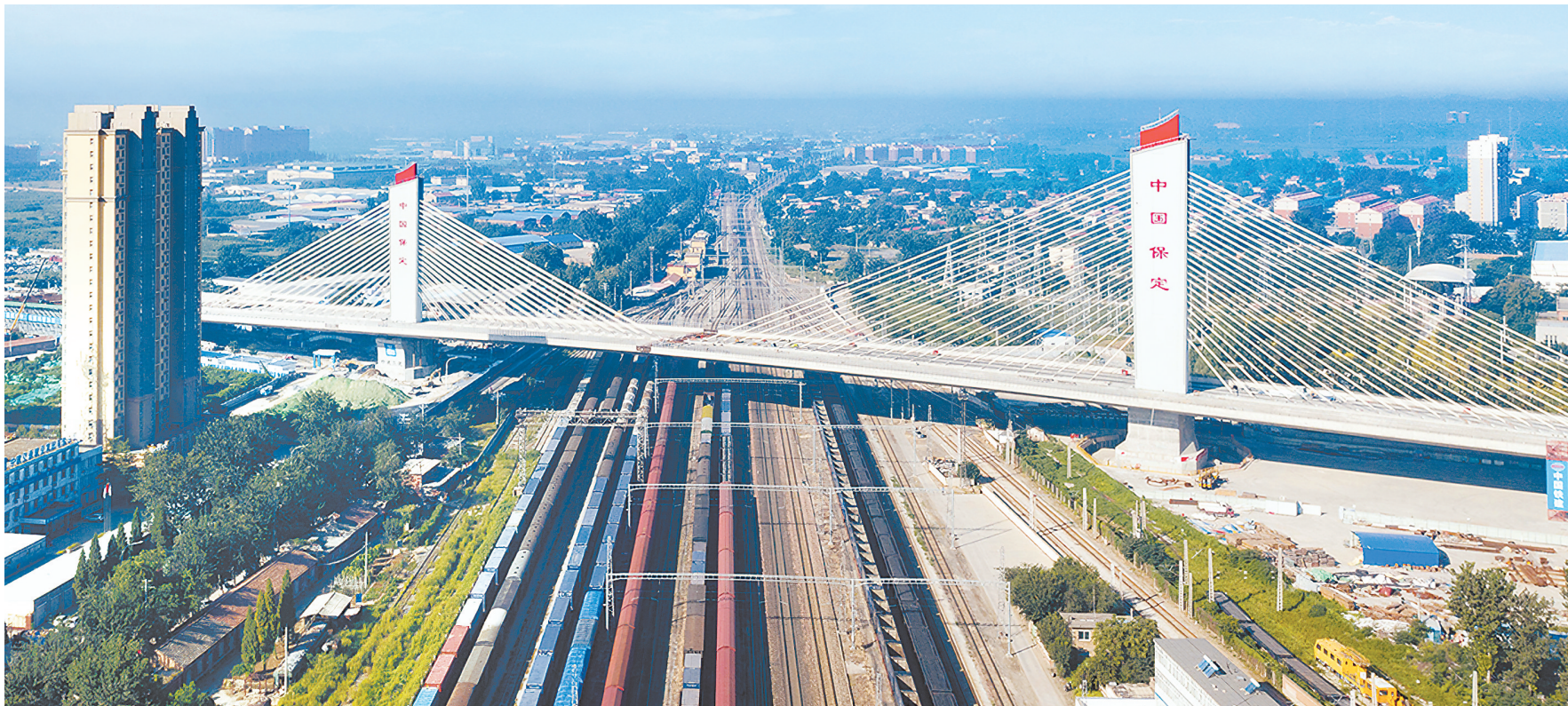
保定乐凯大桥建设。 周刚 摄
