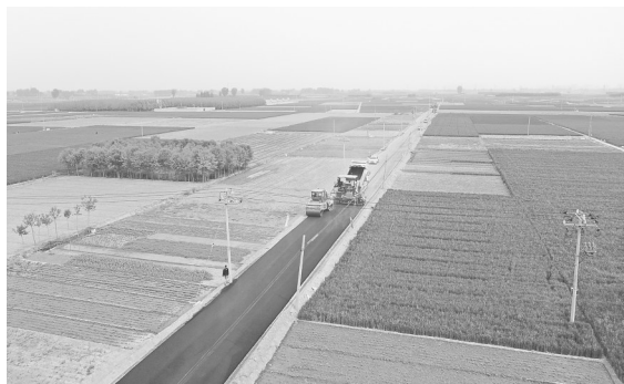
郑章镇“四好农村路”施工现场。 李萌 摄
