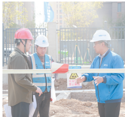
缪鹏飞为城改安置区供水设施铺设提供技术指导。
