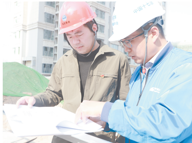
缪鹏飞对照图纸查看供水设施现场铺设情况。
