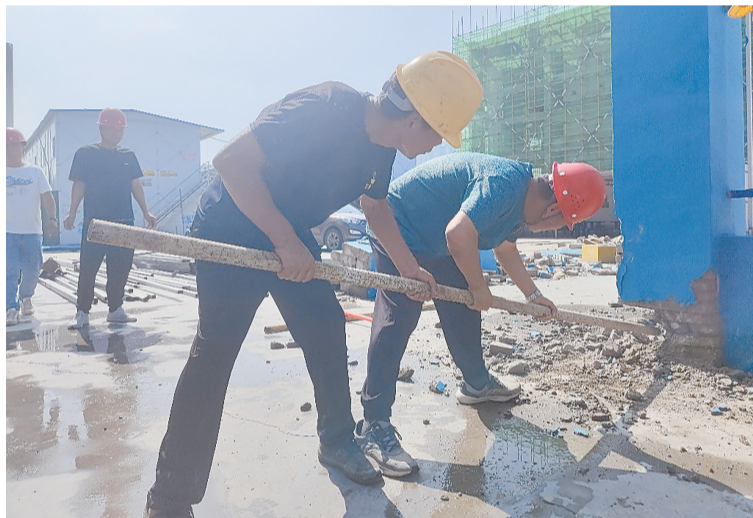
工人们正在拆除的3500平方米工棚,是打通富昌路断头路的关键“堵点”。 郝子帅 摄
