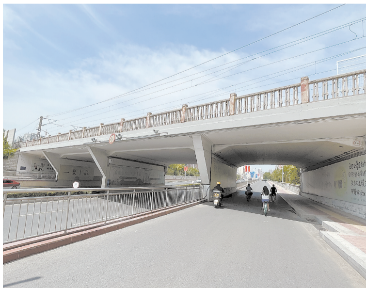
复兴路地道桥粉刷完成。
