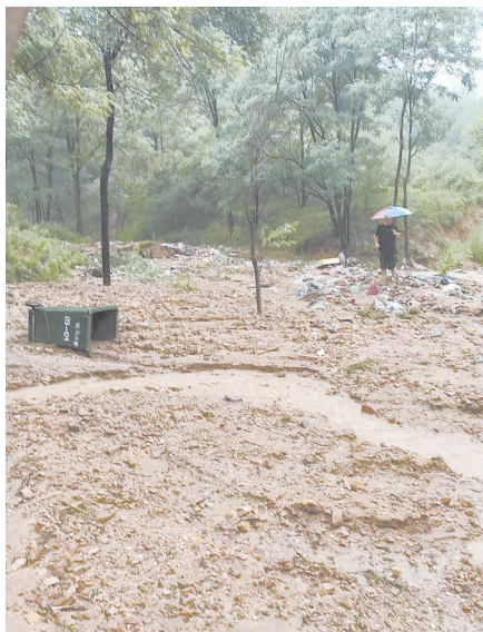
涞源县部分乡镇发生山洪和塌方,与外界失去联系。
