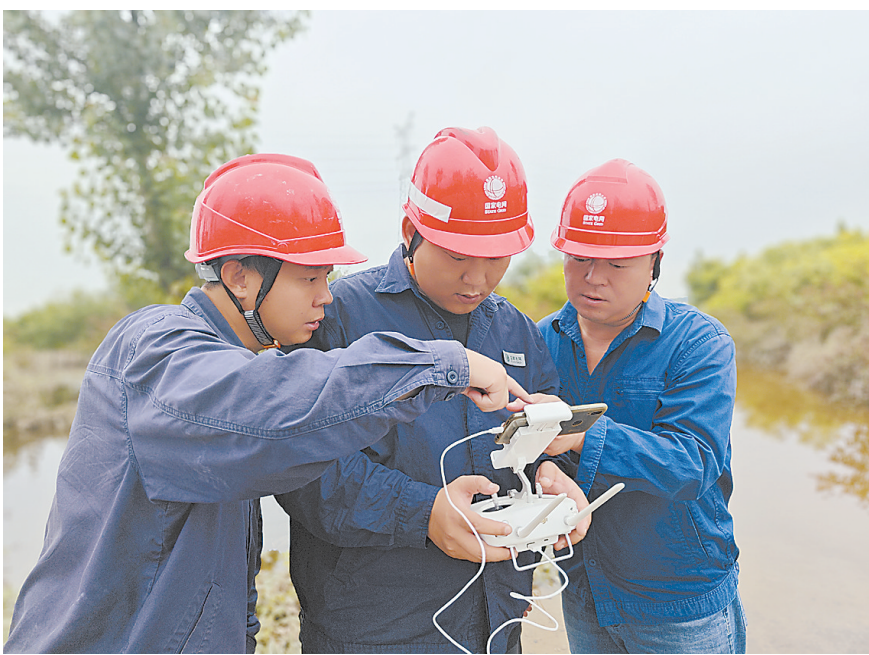
供电人员正在用无人机排查涉水电路受损情况。
