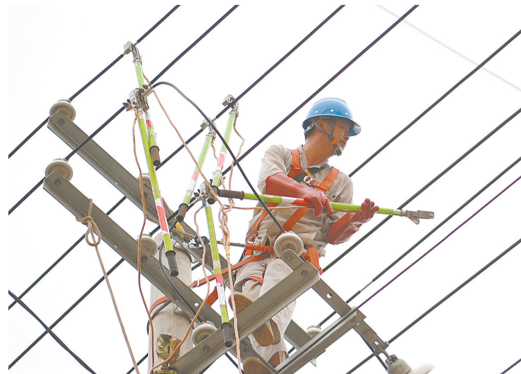
抢修人员在涿州市码头镇向五村抢修电力设施。
