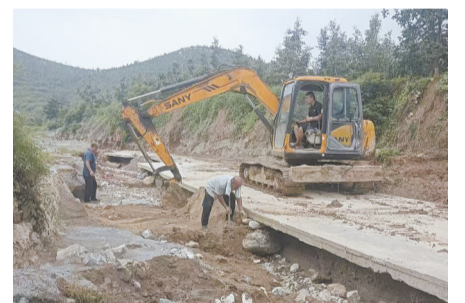
中同龙村对损害的项目路进行修复。
