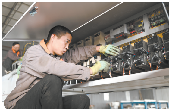
曲阳县众友自动化设备有限公司技术人员正在检测数控机床电气线路。
