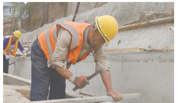
施工人员进行河道墙体装饰。
