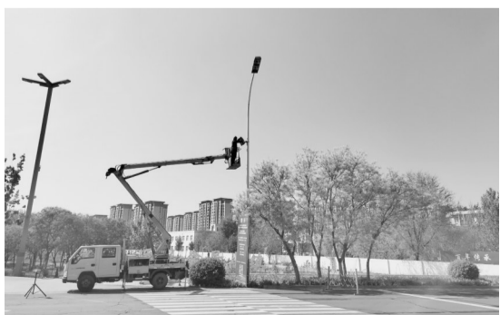
市城市照明管护服务中心加大对赛事沿线照明路灯设施的养护工作。
