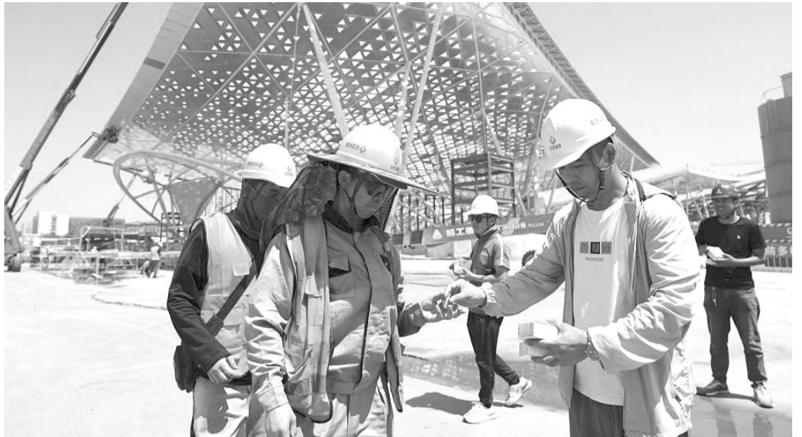
6月12日,在北京城市副中心站综合交通枢纽工程施工现场,北京城建集团的施工人员(左)在领取藿香正气水。 新华社记者 鞠焕宗 摄
