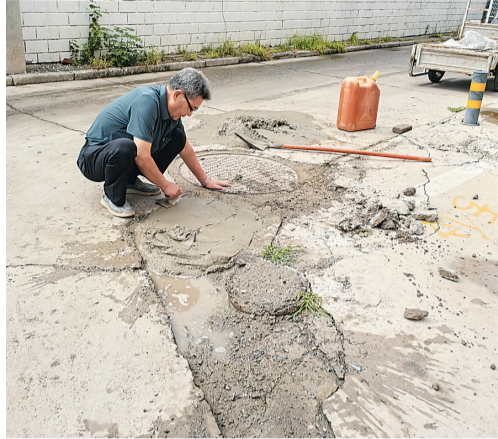
▲工作人员正在修复路面破损处。
