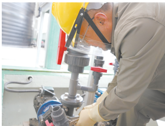
维修人员快速维修故障设备。
