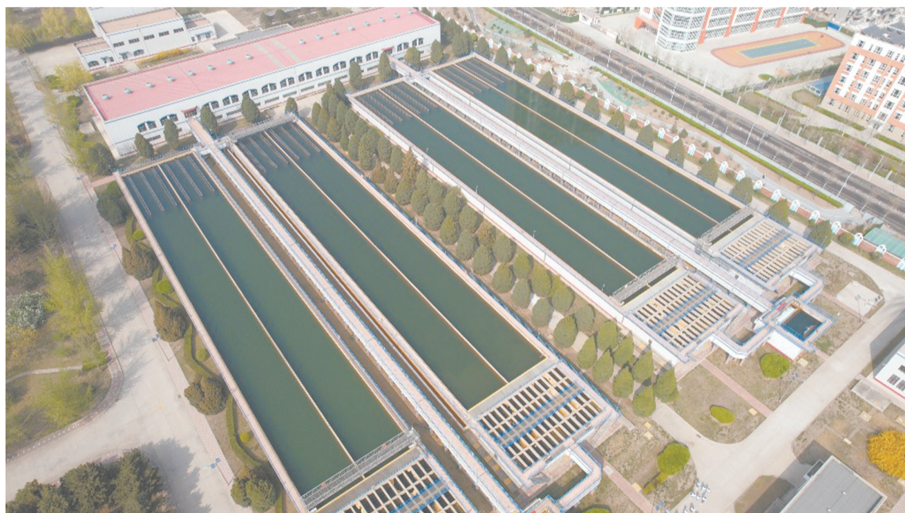
保定市第一地表水厂平流池。
