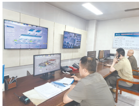
中控室值班人员密切监测水厂各点位运行状况。
