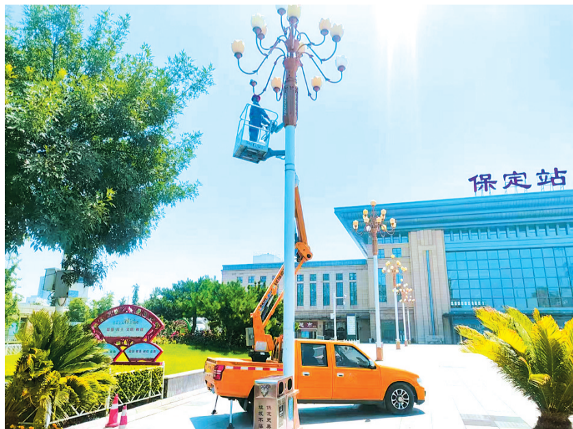
照明人员对火车站两站广场、商业圈等重要点位设施开展集中排查检修、测漏电工作。
