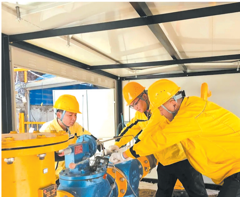
新奥燃气有限公司的设备维护团队对调压柜进行维护保养工作。
