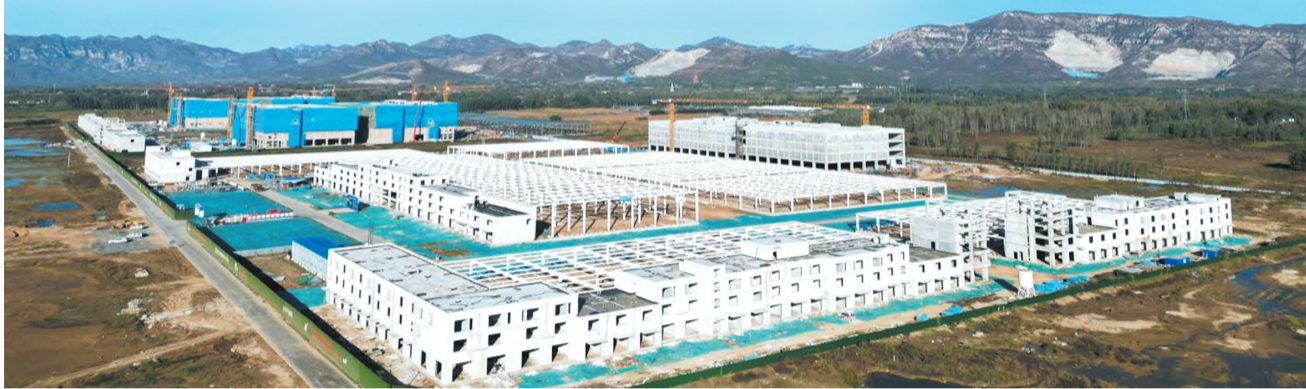
涑水国际花卉产业园项目。
