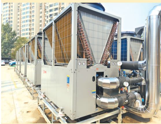
工商局宿舍进行热源改造,采用空气源双模热泵取暖。
