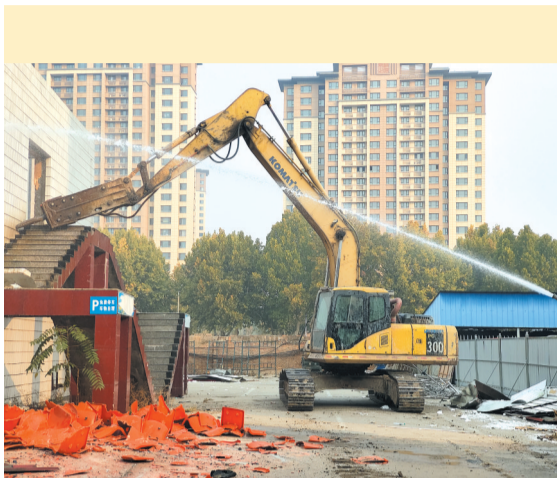
恒兴肿瘤医院2300平方米违建完成拆除工作。
