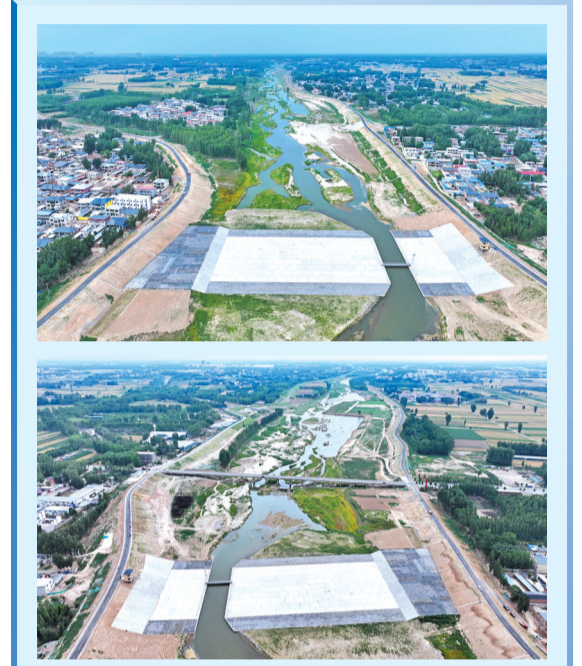
白沟河治理工程(涿州段)完工后的大堤。
