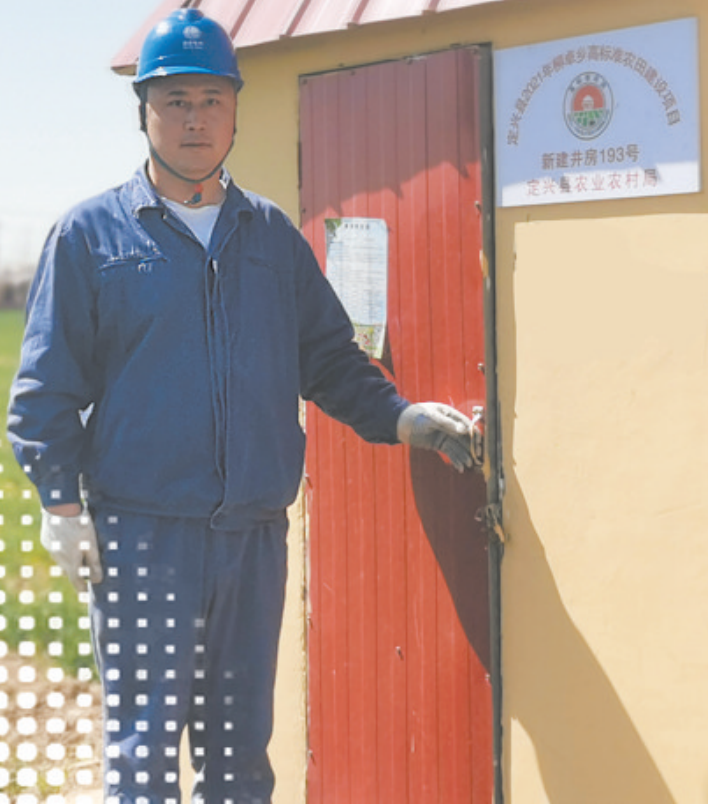
蔡亚仑在定兴县东江村排查维修农排线路。
