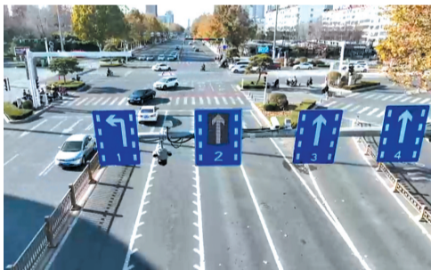
公安交警在40个路口66个方向设置了自适应可变车道,根据流量变化,实时改变车道行驶方向。
