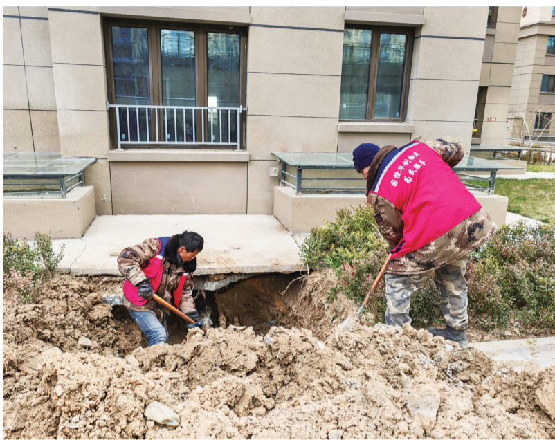
国控华创物业为民服务队工作人员进行维修作业。
