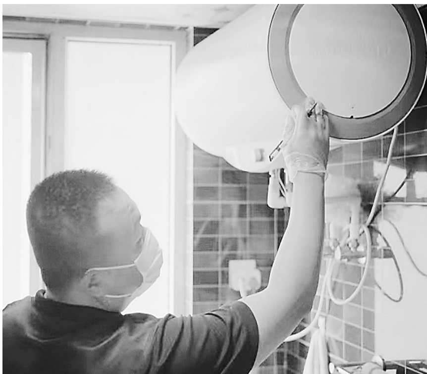
清洗师在做热水器清洗前的检查。
