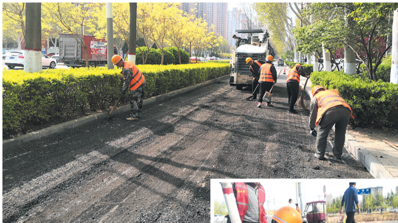
市政维护中心对赛道周边重点路段开展专项维修行动。
