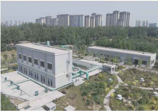
恒祥北大街雨水泵站最大排水能力达到每秒31立方米。 王洪旭 摄
