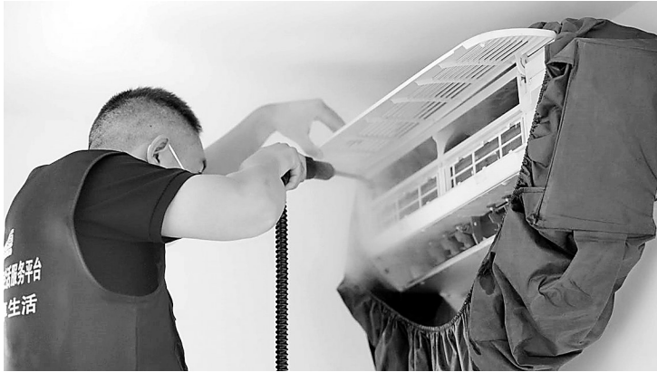
清洗师对空调进行高温蒸汽清洗。
