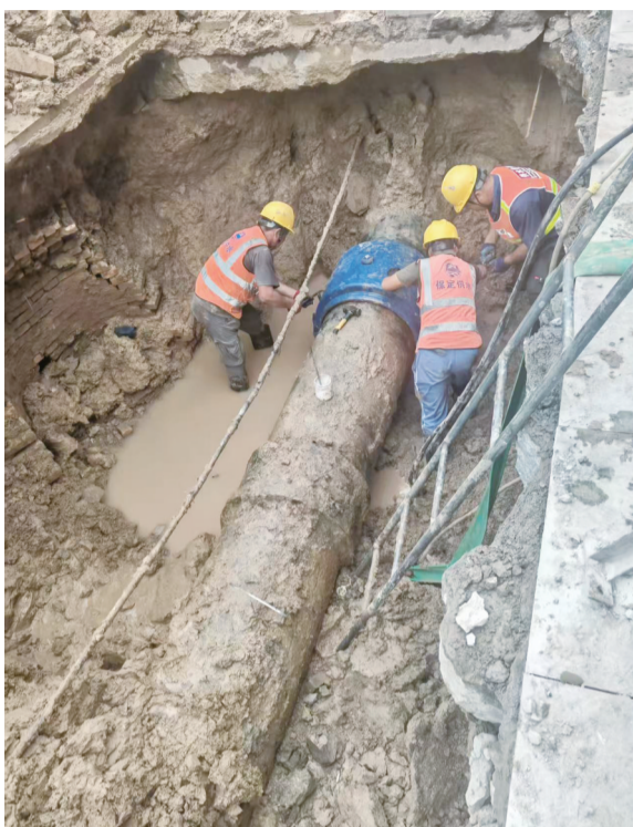
经过近12个小时连续不间断抢修,管道问题有效解决,供水恢复稳定。 赵霜 摄
