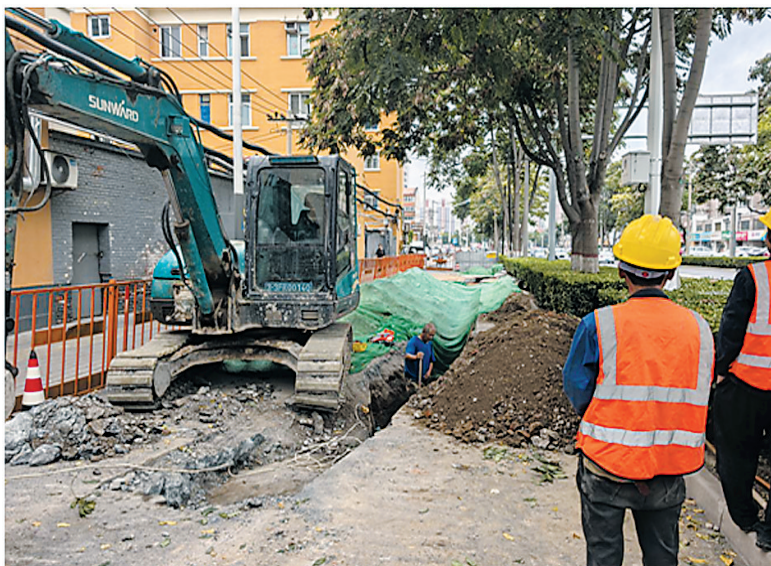
在社区协调下,小区污水管网接入市政主网。
