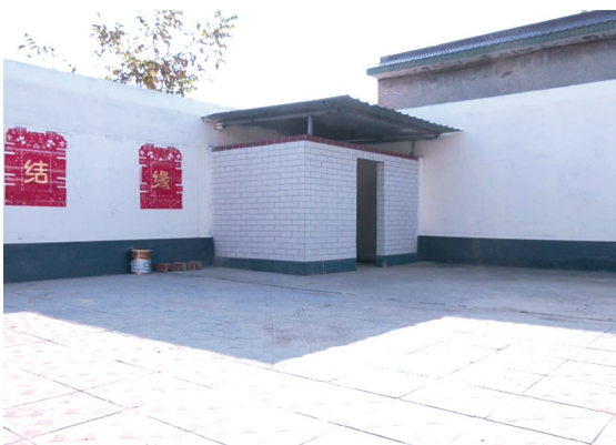
博野县东城镇南陶墟村卫生厕所。(博野融媒供图)
