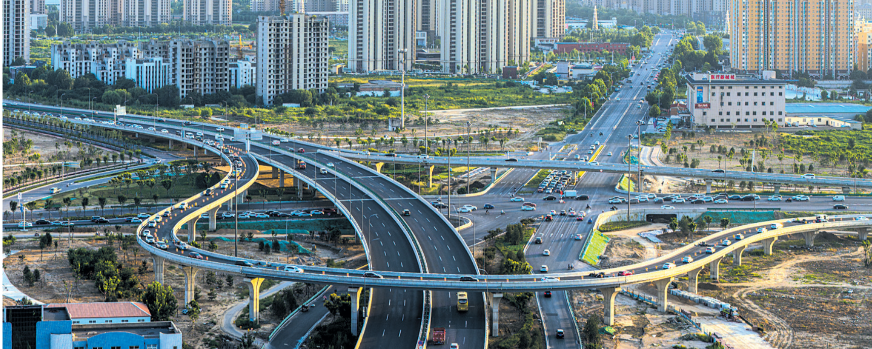
保定东二环快速路与北二环立交桥。
