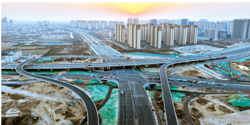
今年元旦,保定东二环快速路五道口立交桥主路贯通。
