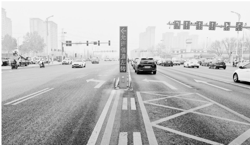
复兴路与长城大街交叉口允许左转的车辆,临时借用对面一条车道。耿静 摄
