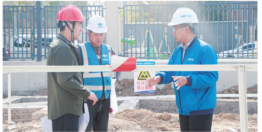
保定供水公司工作人员为城改安置区供水设施铺设提供技术指导。
