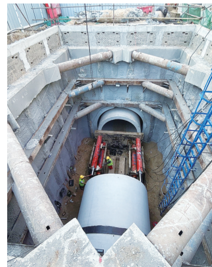
在防洪排涝施工现场,保定供水公司用液压千斤顶进行管道顶进施工。
