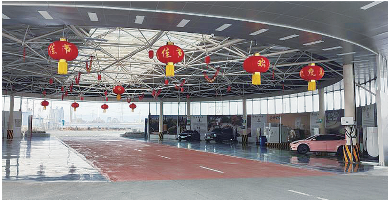
春运路上,在甘肃接驾嘴近零碳服务区,新能源车辆通过“光储充超级充电站”实现20分钟快速补能。
