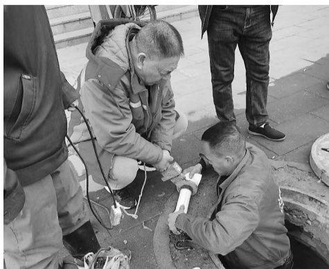
▲工作人员正在紧张抢修中。
